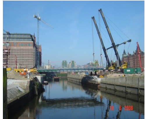
Brooktorhafenbrücke während Vershub
