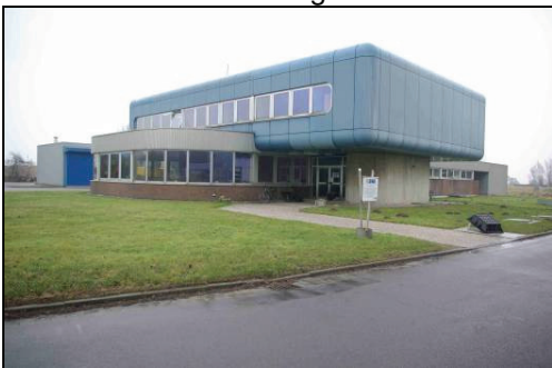
Betriebsgebäude in Bestand
