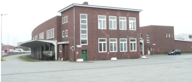
Fischhallen VII u.VIII vor Baubeginn im November 2011
